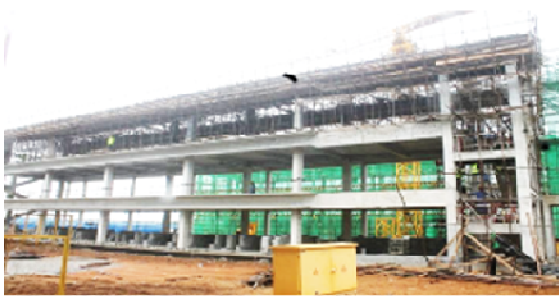
Construction du Lycée d'excellence de Grand-Bassam
