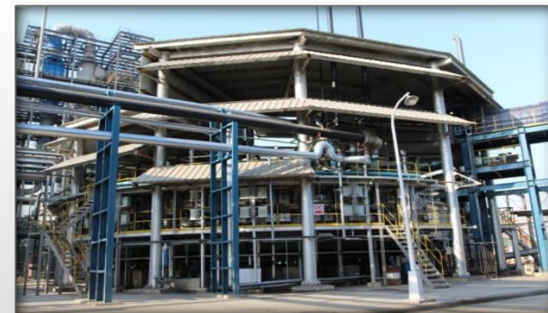
蓄热式旋转床反应系统
