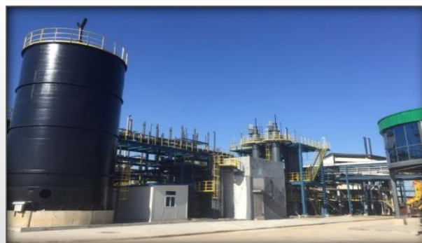
油气净化、储存系统
