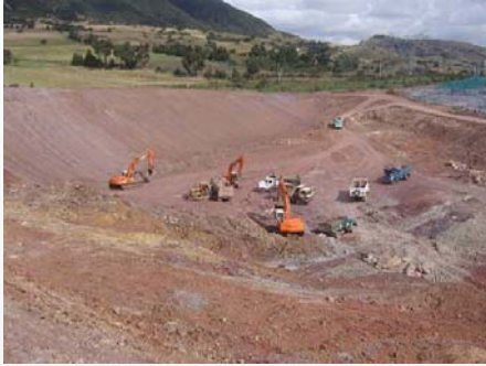
Adecuación de zonas para disposición de residuos
