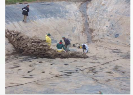
Mantenimiento de Pondajes
